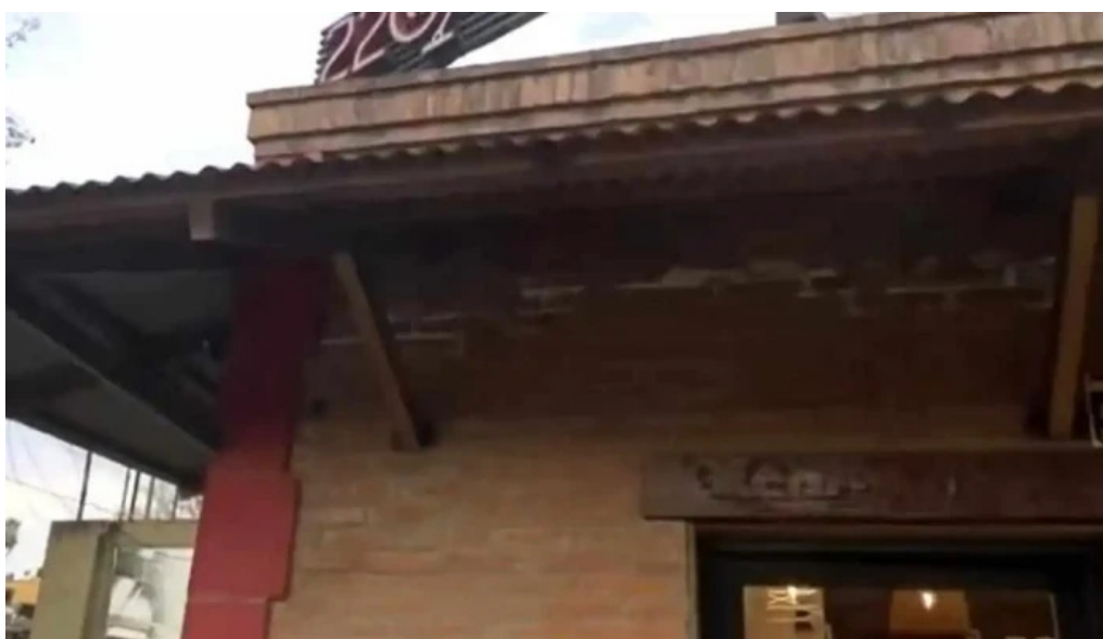
Dos veinte espacio de iluminacion del propietario
