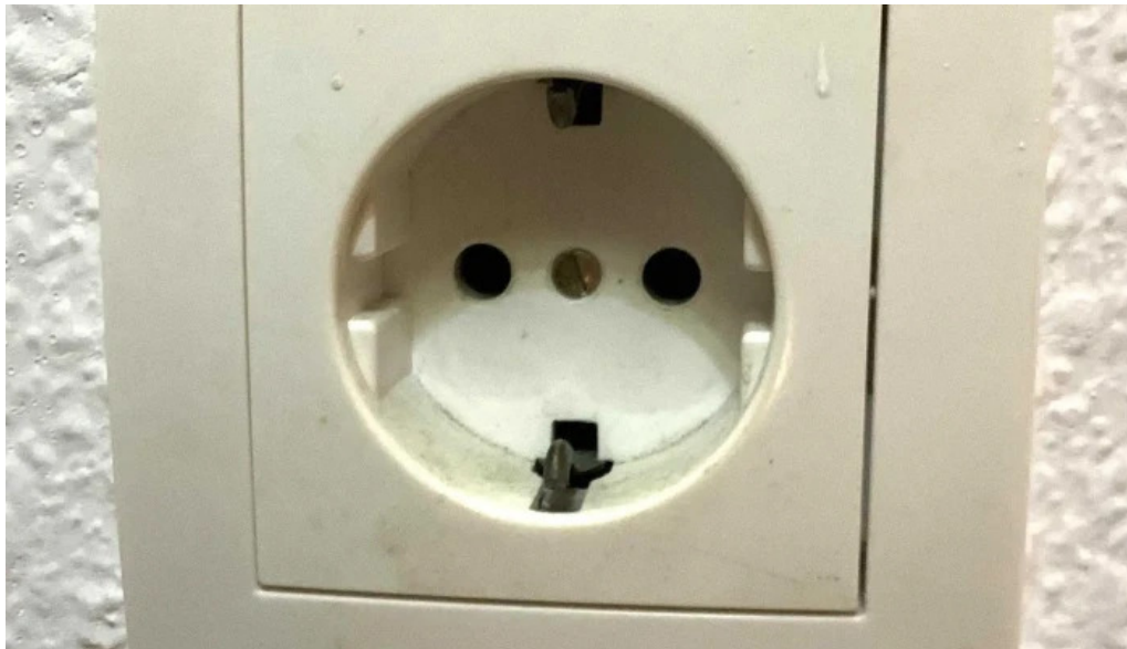
Electricidad lujan lujan de cuyo
