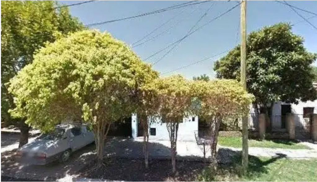
Mi servicio de mantenimientos abierto ahora deg
