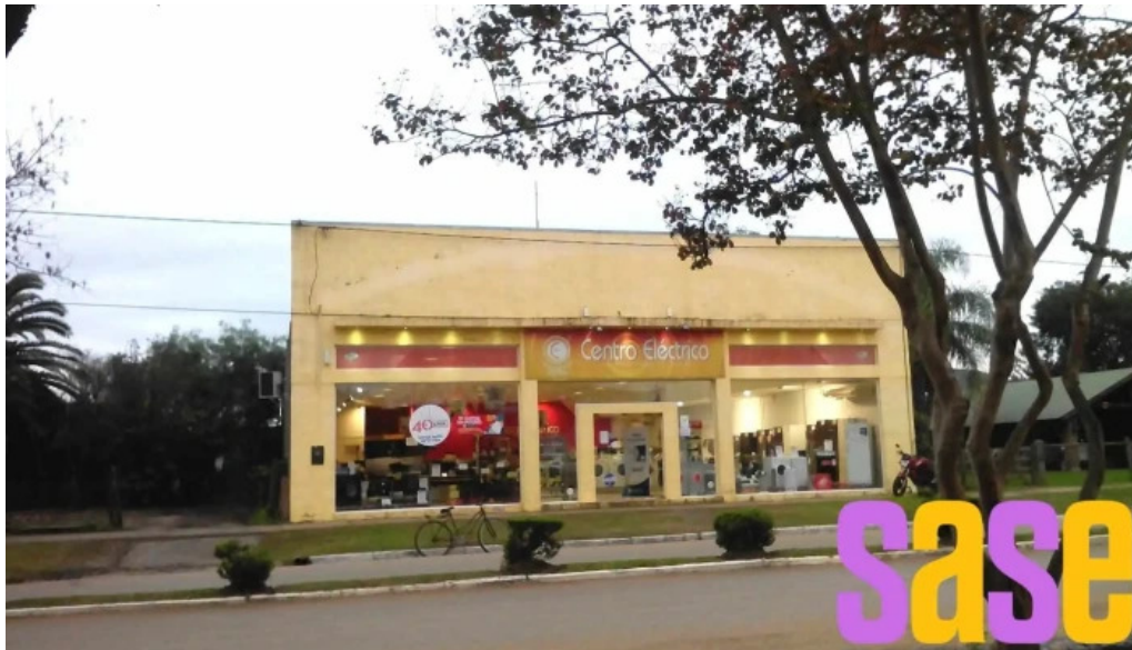
Centro electrico federal
