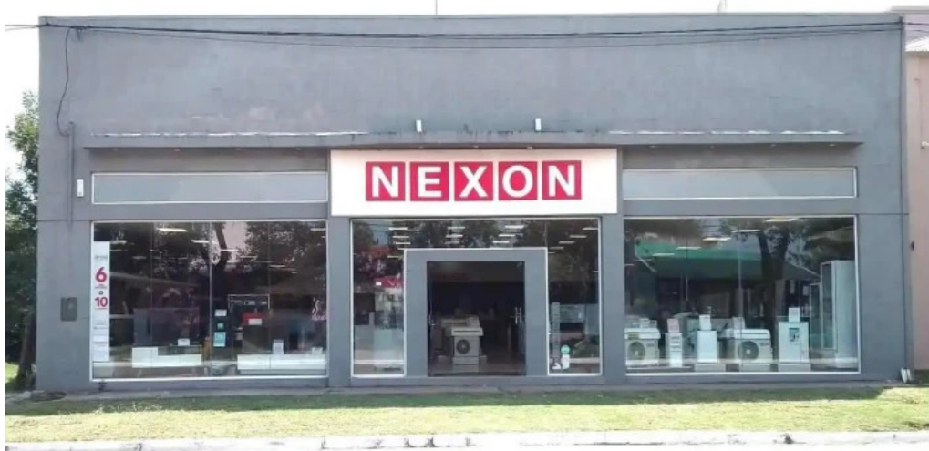
Centro electrico del propietario
