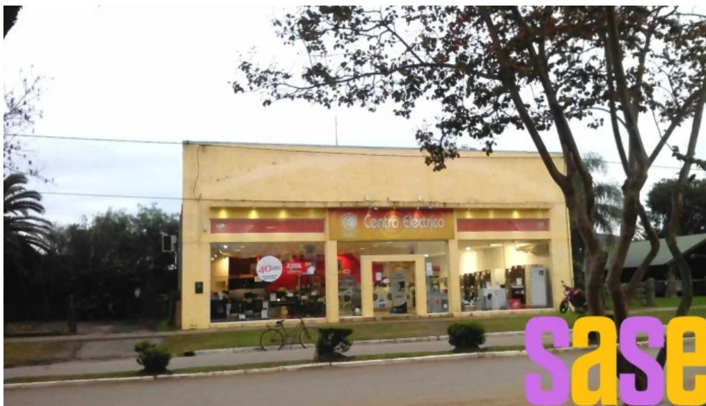
Centro electrico abierto ahora
