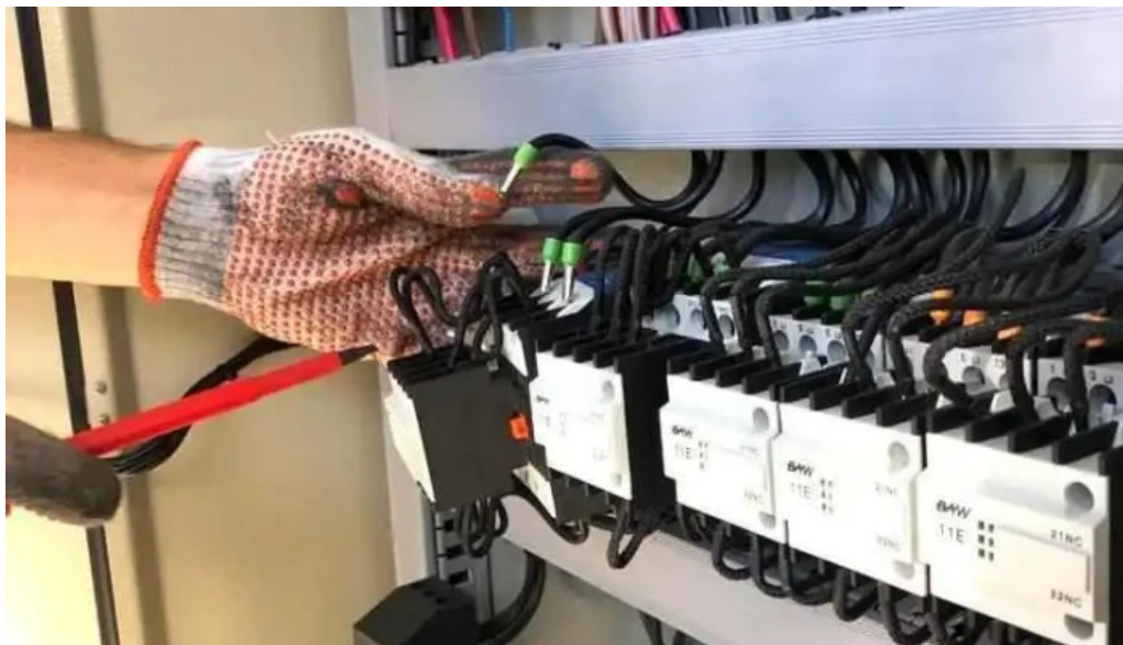
San carlos electricidad interior
