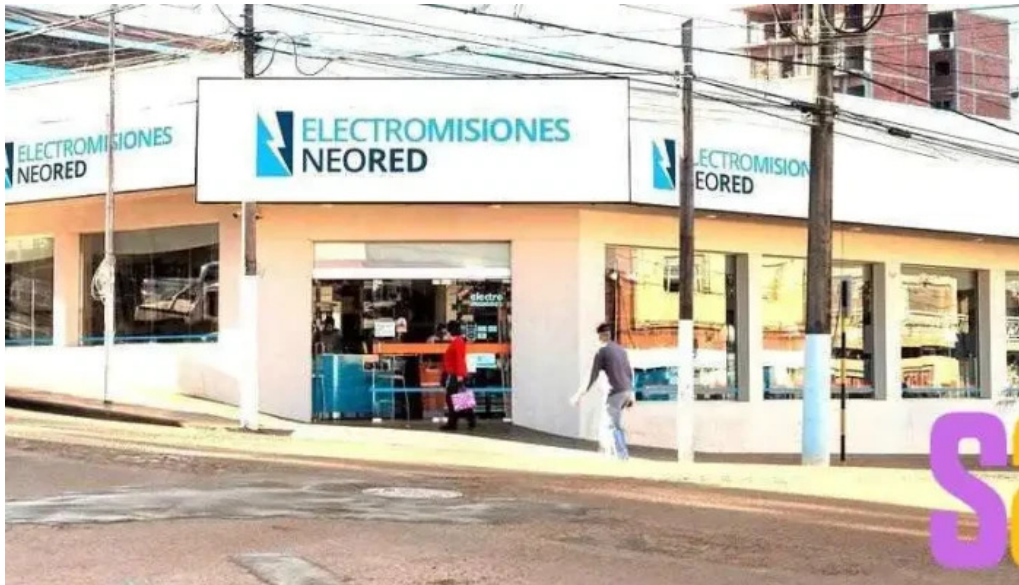
Electro misiones neored obra obra
