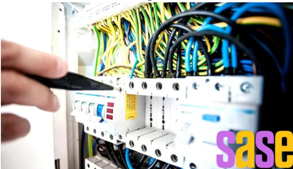
Corpus sa materiales electricos san luis
