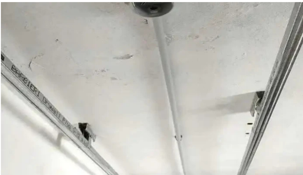
Induelectric proyectos y soluciones electricas rio cuarto
