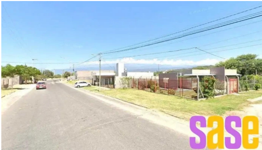
Mecanica y electricidad san fernando del valle de catamarca
