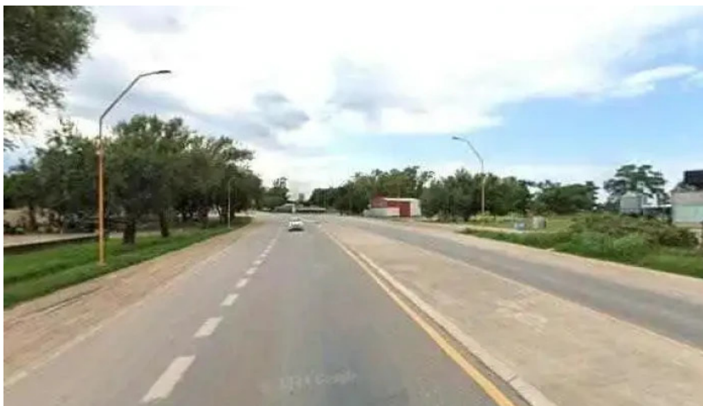
Apse servicio electrico precios
