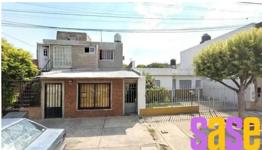
Refrigeracion y electricidad jorge gomez rosario
