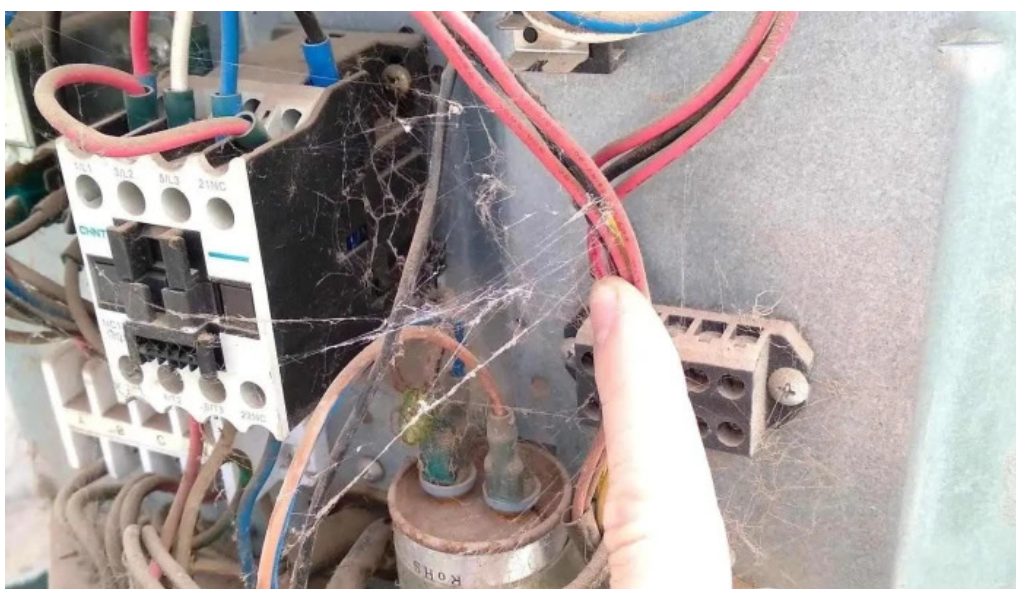
Ecoambientar refrigeracion aire acondicionado electricidad e iluminacion del propietario
