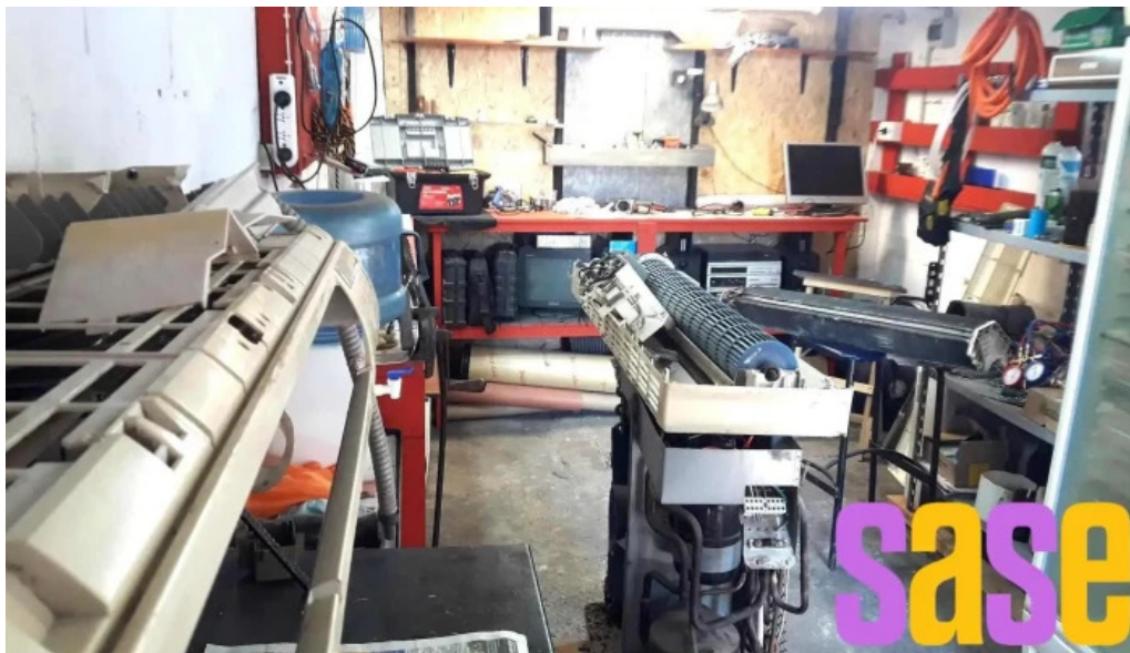
Sdf electricidad refrigeracion interior
