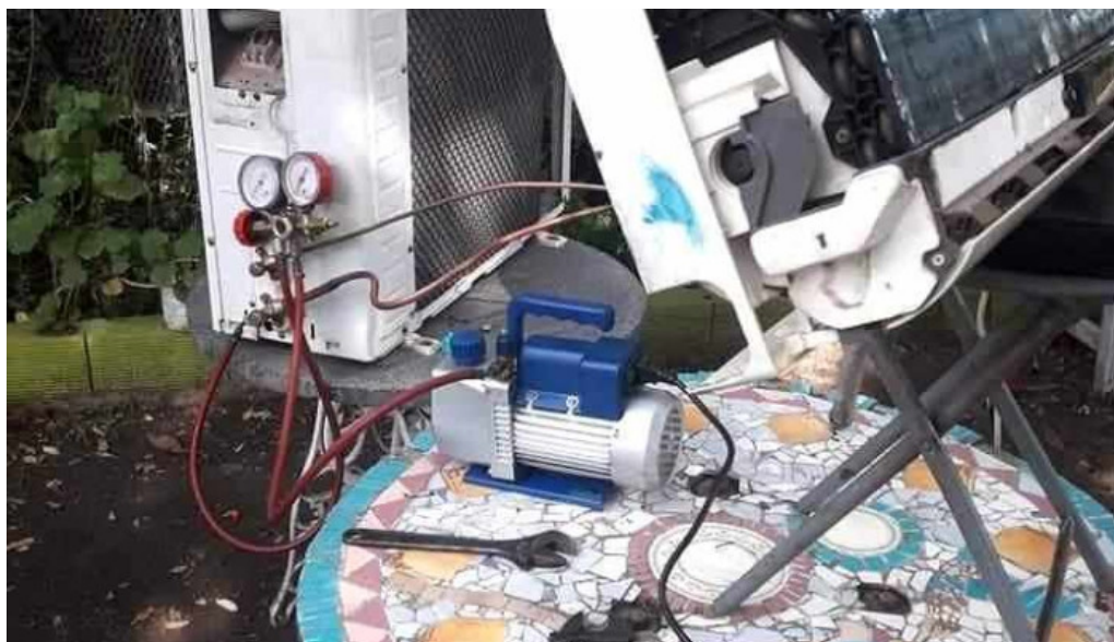
Jr instalaciones refrigeracion instalacion de aires acondicionados y electricidad descuentos
