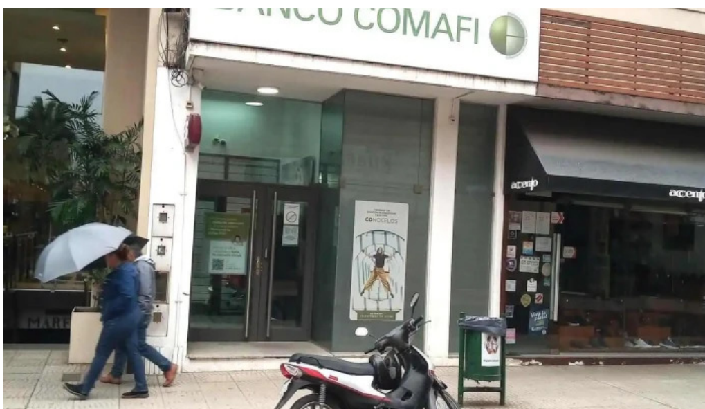
Er electricidad refrigeracion exterior
