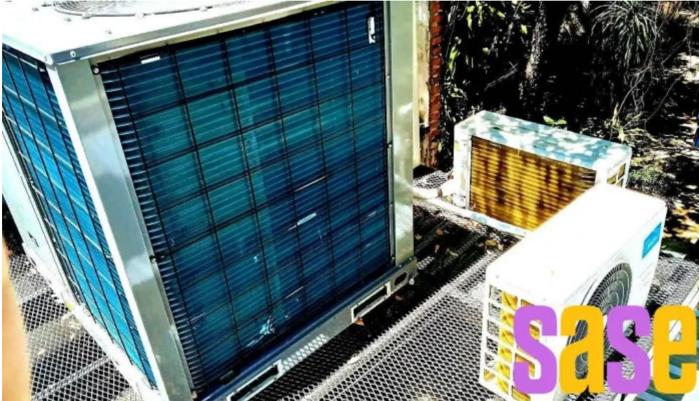
Er electricidad refrigeracion resistencia
