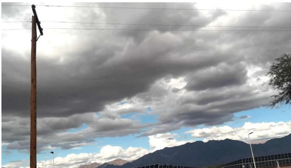
Parque solar fotovoltaico tinogasta direccion
