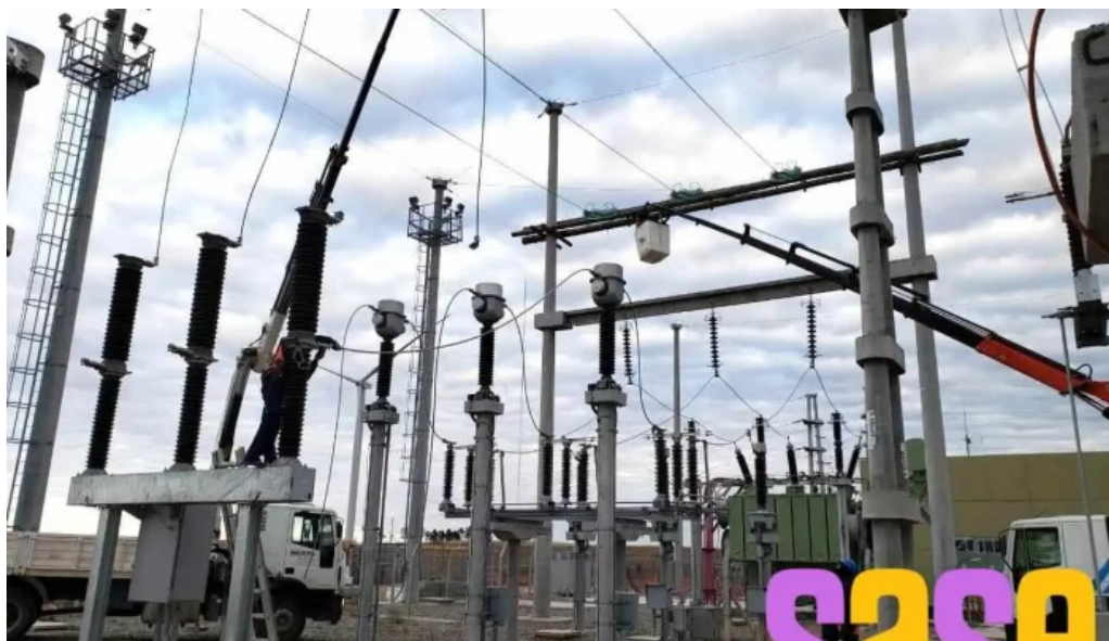
Ingesa ingenieria electrica sa interior
