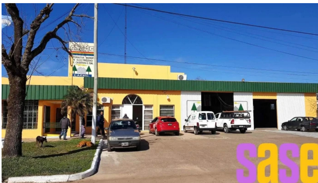
Cooperativa agropecuaria y de electricidad monte caseros Ltda edificio
