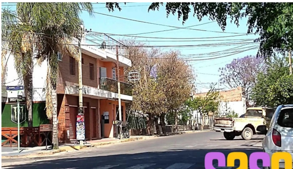
Oficina comercial de epec donde
