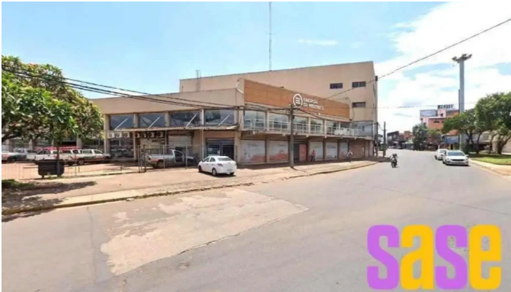
Energia de misiones posadas
