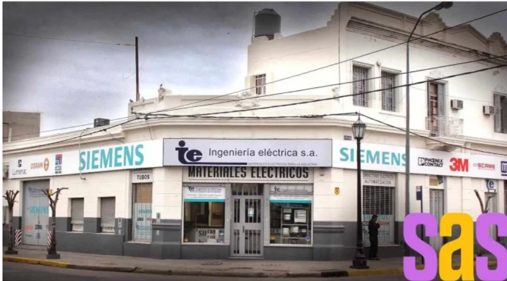
Ingenieria electrica sa edificio
