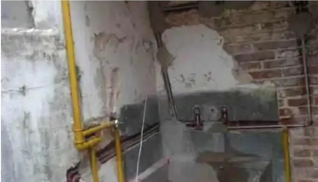
Cristian ravelli servicios para la construccion fotos
