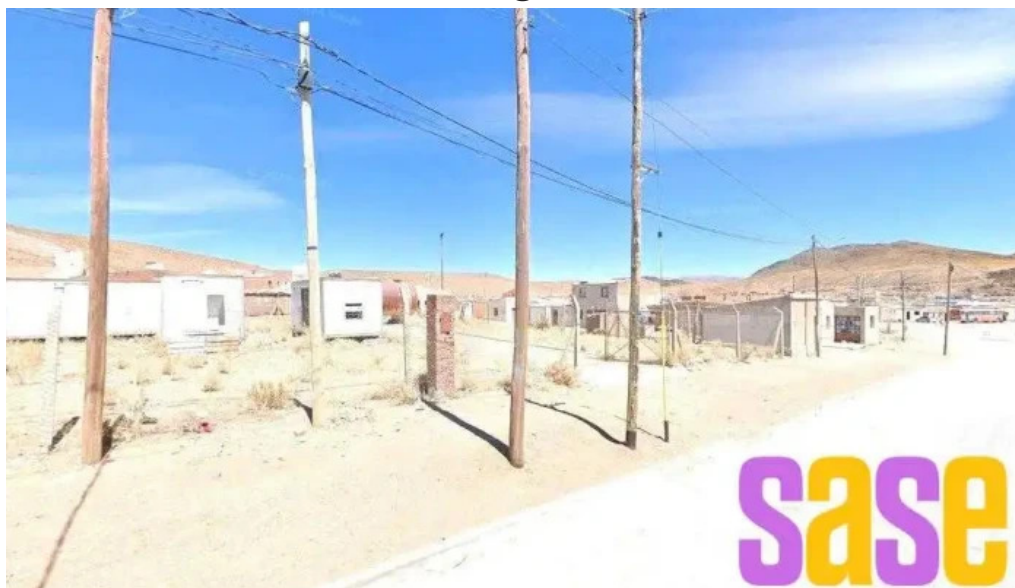
Enel x charging station san antonio de los cobres
