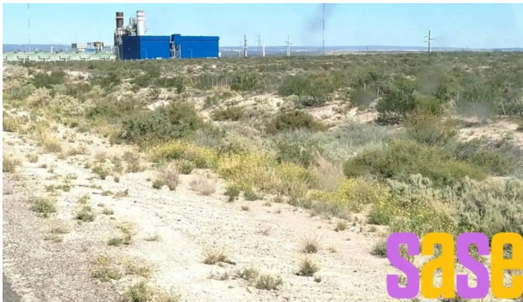
Central termica roca sa videos
