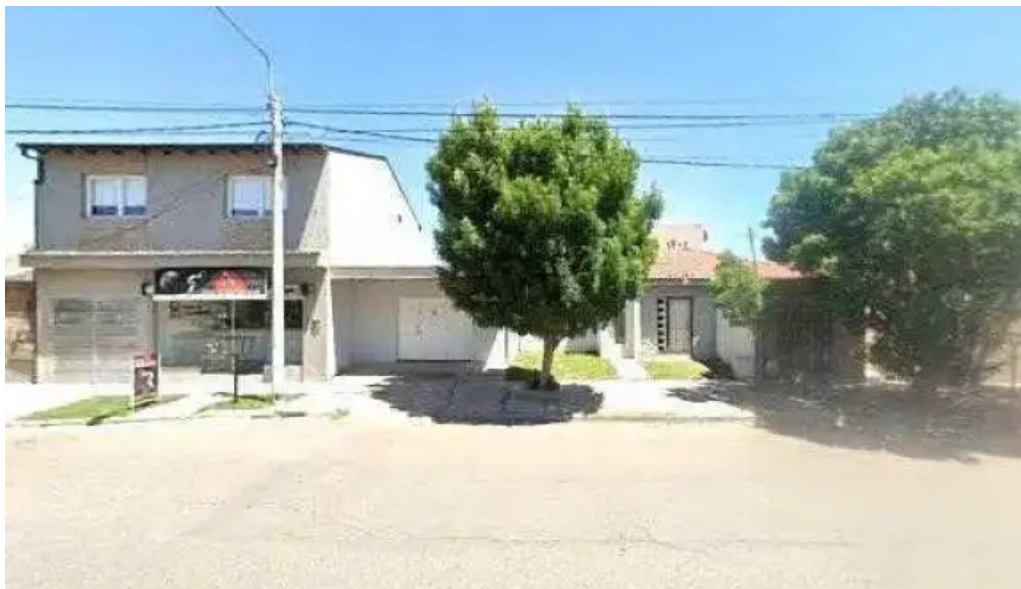
La casa de electricidad cerca de mideg
