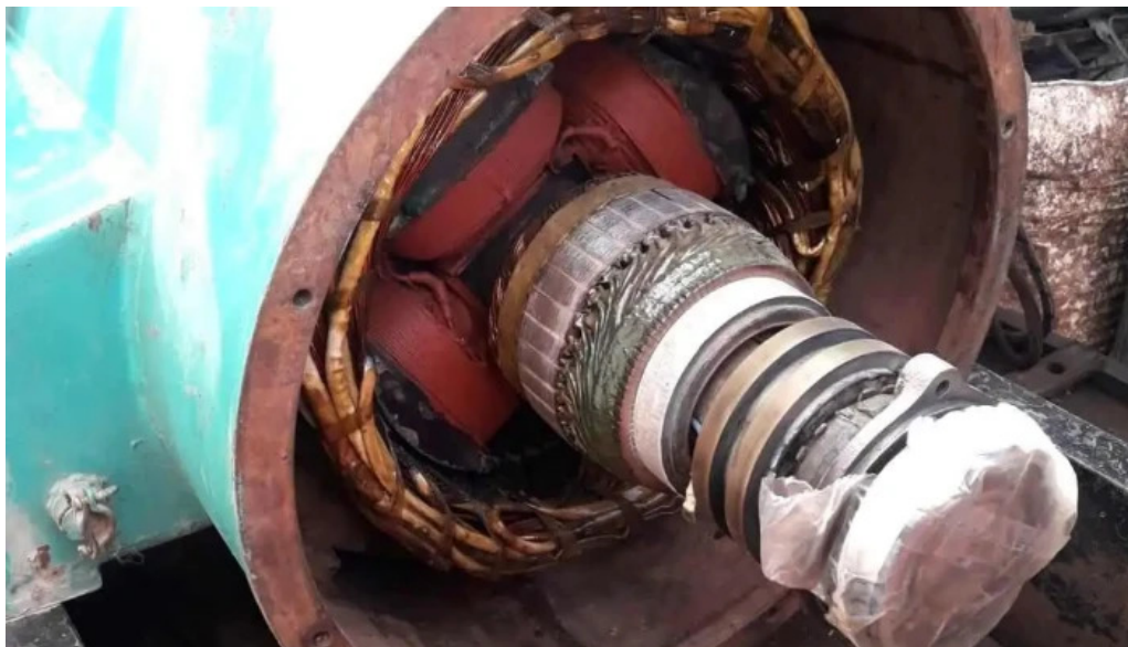
Electrical servicesservicio tecnico de grupos electrogenos del propietario
