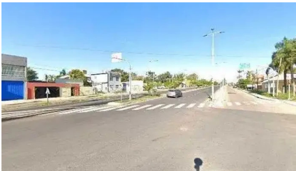
Electricidad parana cerca de mi
