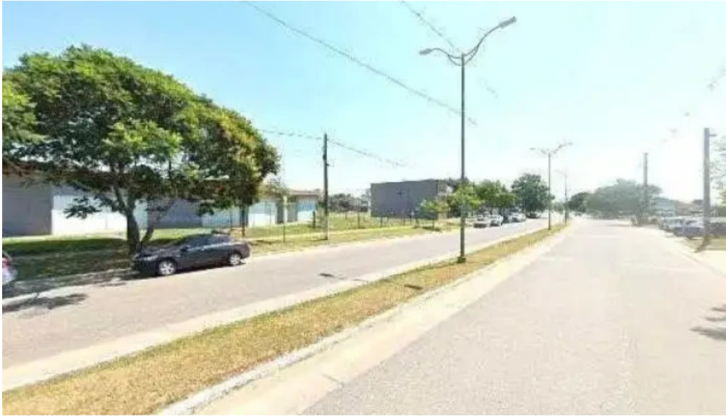
Oeste electricidad zona
