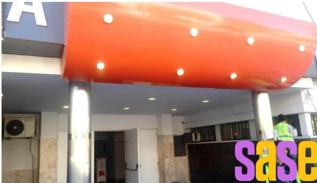
Ja electricidad del propietario
