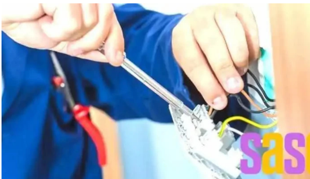
Gustavo paniagua tecnico en electricidad y aires acondicionados del propietario
