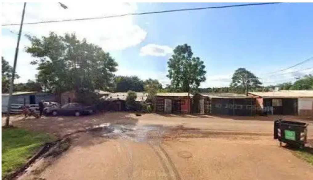
Electricidad en general ubicacion
