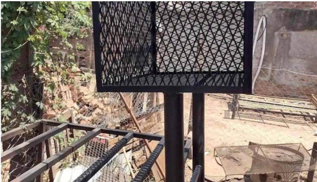
Jb electricidad pampa de los guanacos
