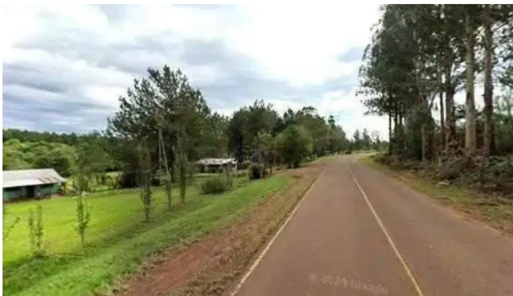
Reparaciones franco fotos
