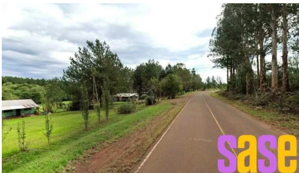
Reparaciones franco leandro n alem
