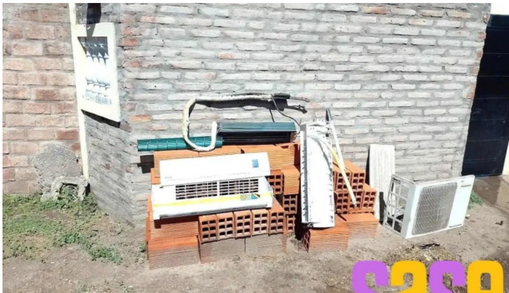
Cmf electricidad refrigeracion la banda
