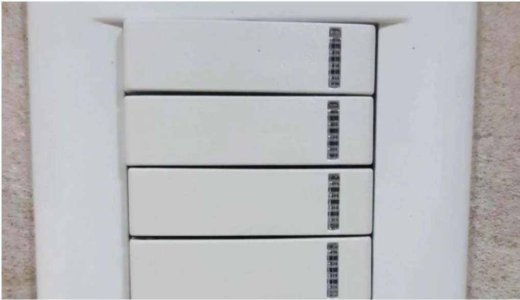
Prokopiuk electricidad pinturas sitio web
