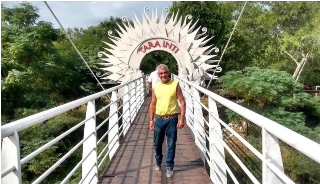
Dique frontal rio hondo puente
