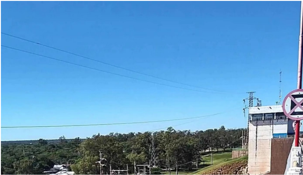
Dique frontal rio hondo ubicacion
