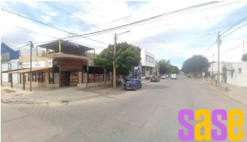
Cooperativa de provision de energia electrica zapala ltda zapala
