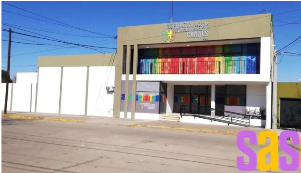
Cooperativa de obras y servicios públicos de canals canals
