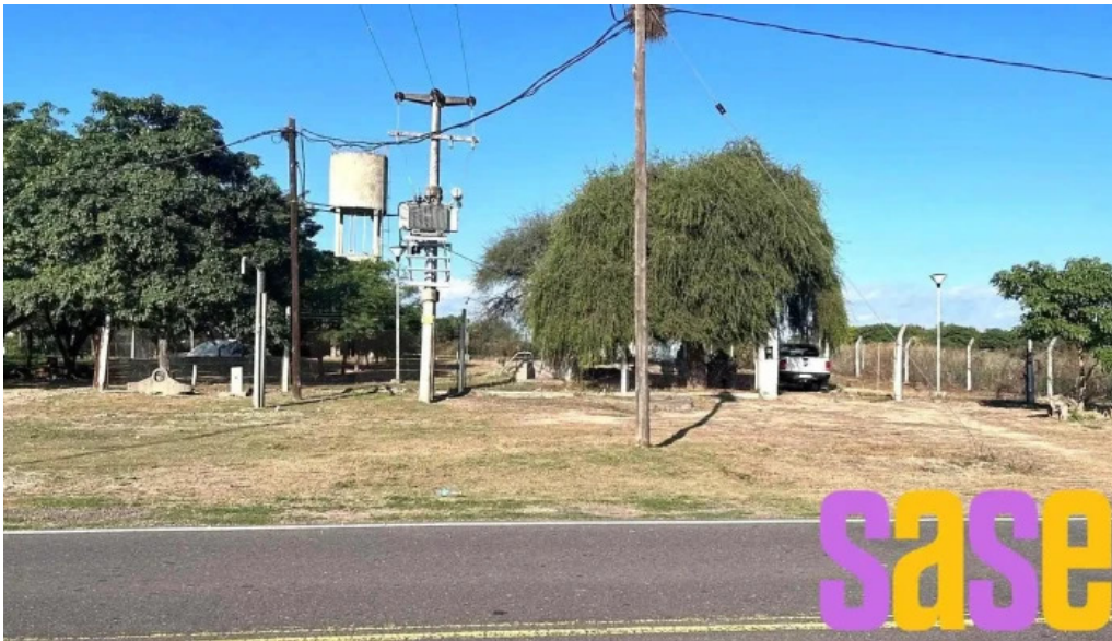
Estacion de bombeo diosse villa rio hondo
