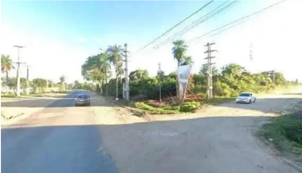
Dpec estacion transformadora fotosdeg
