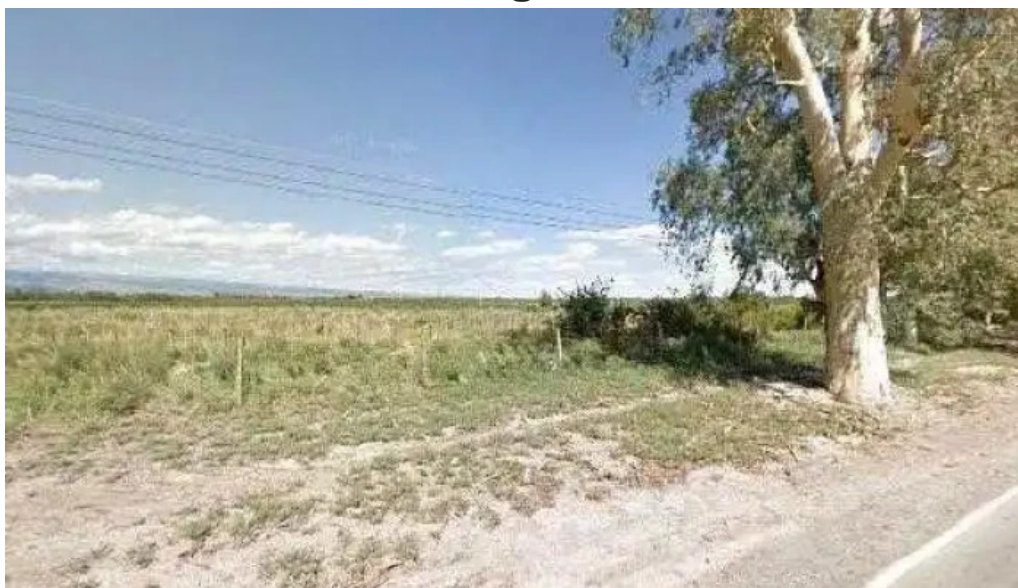
Estacion transformadora 9 de julio zona
