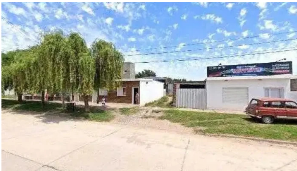
Electricidad olivera telefonodeg
