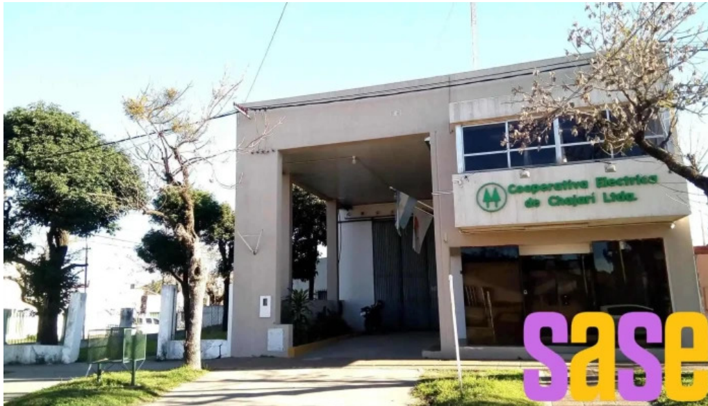
Cooperativa electrica de chajari ltda telefono
