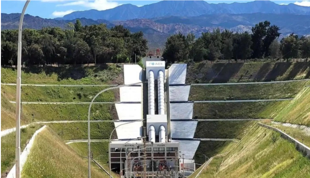
Central hidroelectrica aes ullum la olla fotos
