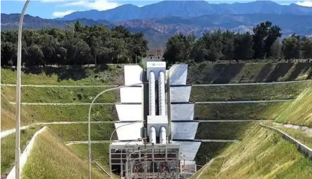
Central hidroelectrica aes ullum la olla ullum
