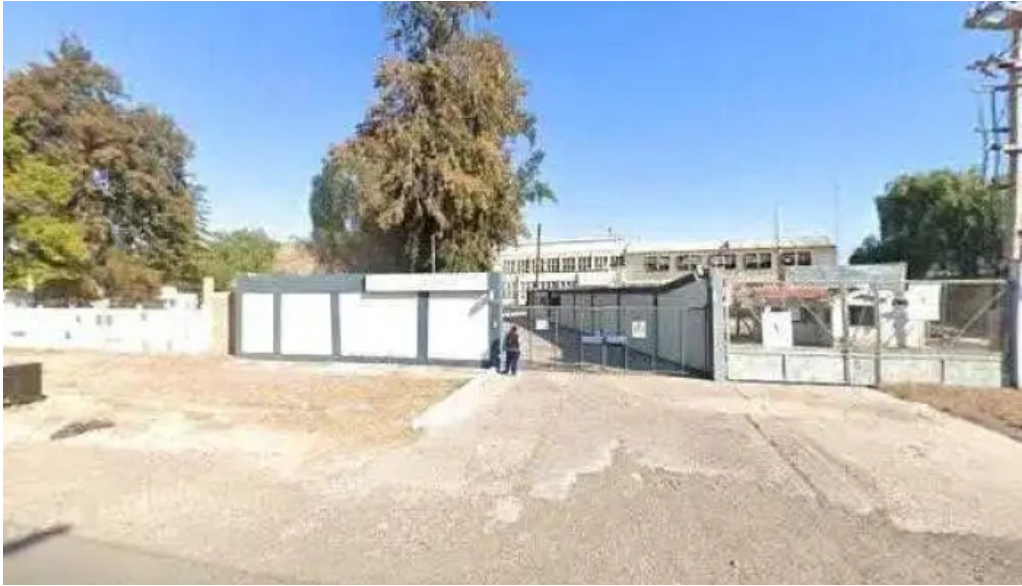
Aes central termica sarmiento sitio web
