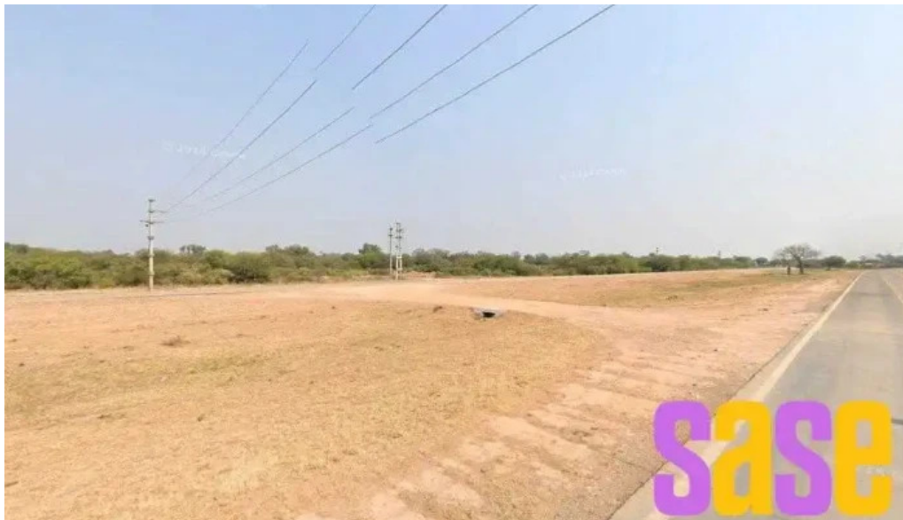
Central electrica ing juarez ingeniero juarez
