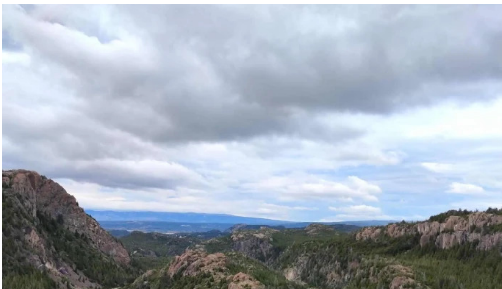
Complejo hidroelectrico futaleufu direccion
