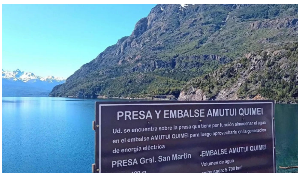
Complejo hidroelectrico futaleufu chubut
