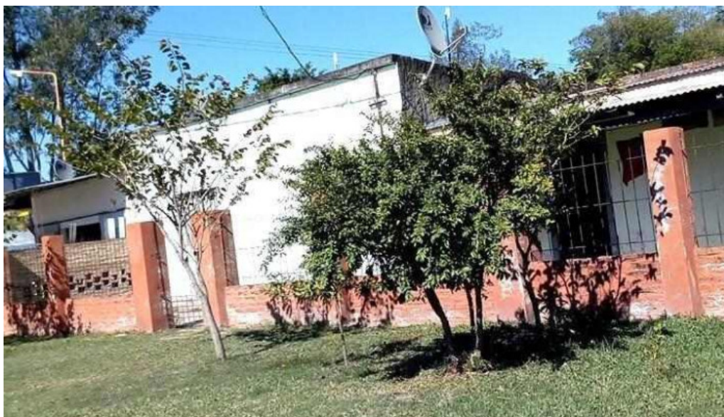
Villa escolar exterior
